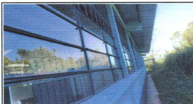
Foto 3: MÓDULO 1 AULAS: VENTANAS: Sustitucion de vidrios.
