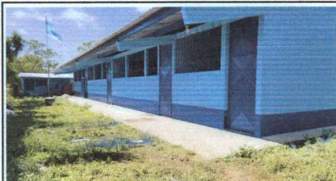
Foto 2: MÓDULO 1 AULAS: PUERTAS DE METAL: Mantenimiento a estructura ( lijado ,cambio de tubo, cepillado, sujeciones, aplicación de pintura), Cambio de chapa.
